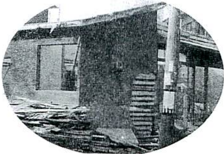
建てかえ工事中の齊美会館
