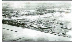
①鶴見工業地帯「日本鋼管渡田工場」
